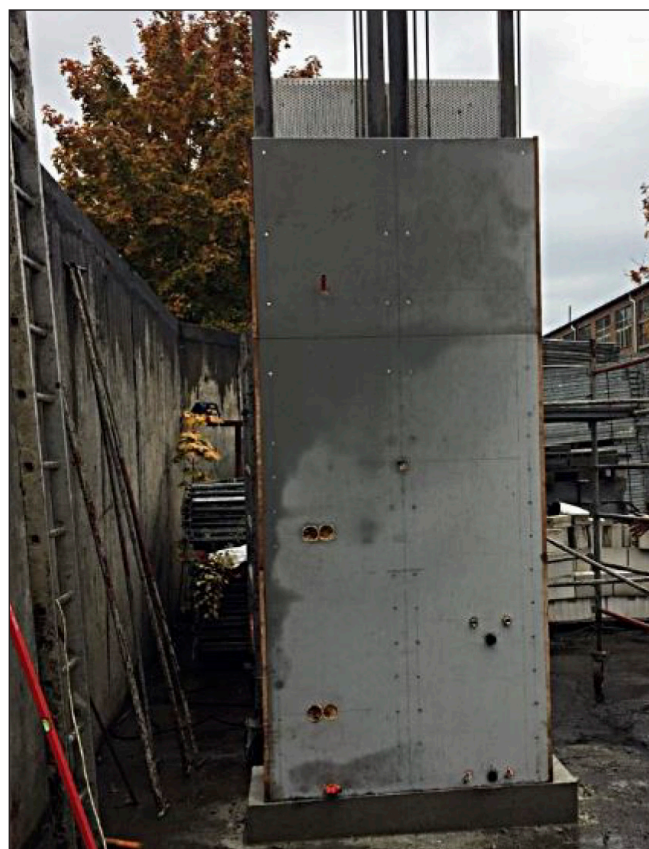
15. ábra: Falelem próbaszerelése
